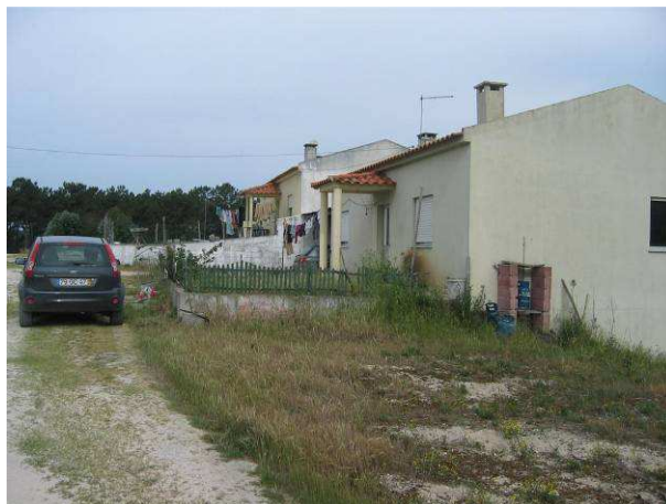
Fotografia 3.13 - Vista para as habitações junto à unidade C.
