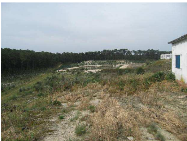
Fotografia 3.16 - Vista para o sistema de lagunagem e para o terreno florestal, a sul.
