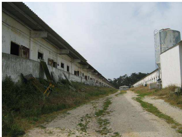
Fotografia 3.8 - Vista para a unidade C, entre os edifícios de produção 6 e 8.
