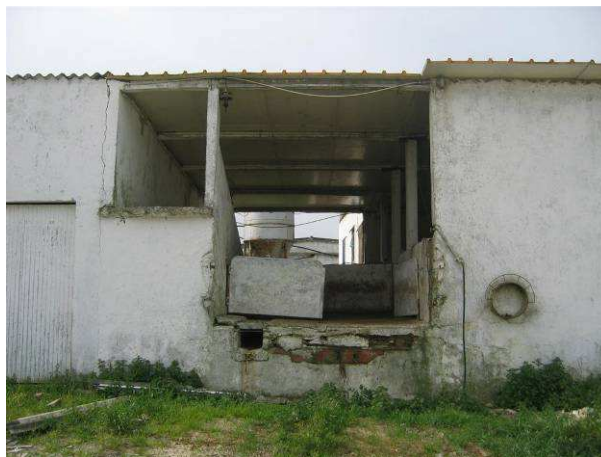
Fotografia 3.2 - Vista para cais de embarque na unidade B, no topo do edifício de produção 4.
