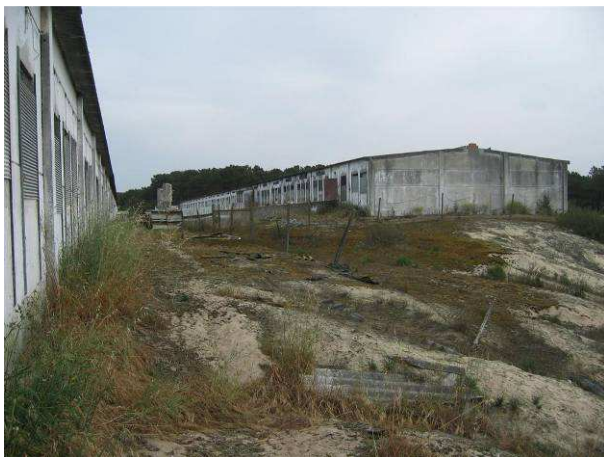
Fotografia 3.7 - Vista para a unidade C, de sul para norte, entre os edifícios de produção 5 e 6.
