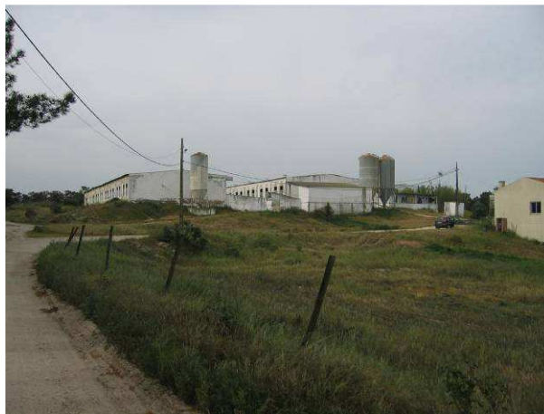
Fotografia 3.6 - Vista para a unidade C, edifícios 5 e 6 e silos.
