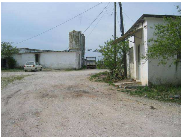
Fotografia 3.3 - Vista para o escritório, arrumos e silos na parte norte da exploração.
