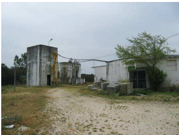
Fotografia 3.10 - Captação de água e depósito.
